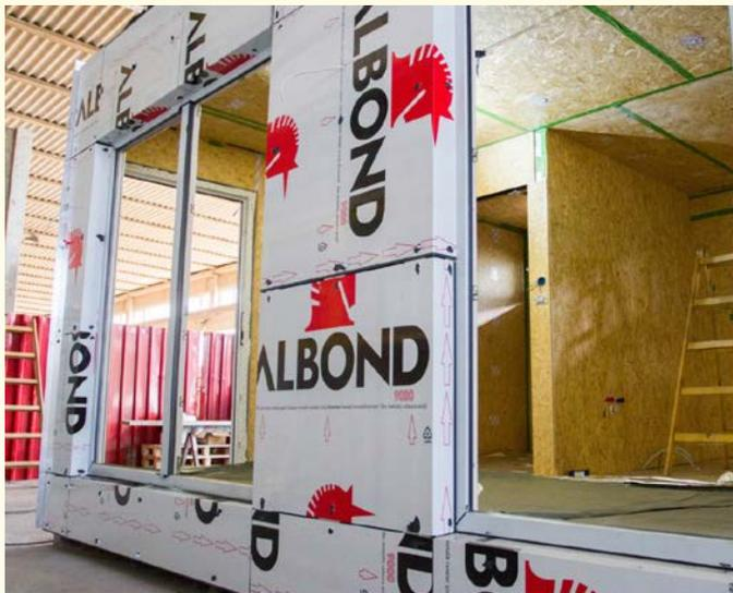
Die Abmessungen der MEH-Basismodule betragen 600 x 250 cm und 300 x 250 cm. Die Standardgrößen wurden an den Transport und die Montage angepasst, damit die Kosten minimal bleiben.
